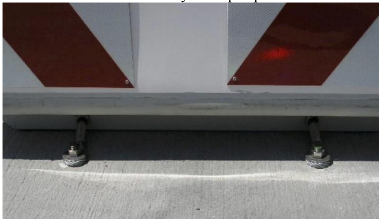
Obrázok č. 2: Zaistenie fixačných lán pod prednou časťou tlmíča
