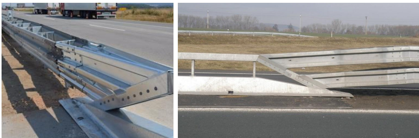
Foto 5 – možnosti napojenia na betónové zvodidlo typu NEW JERSEY
