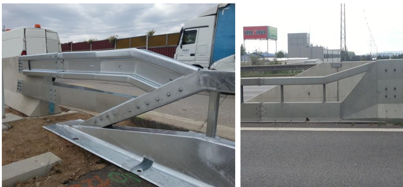
Foto 5 – možnosti napojenia na betónové zvodidlo typu NEW JERSEY
