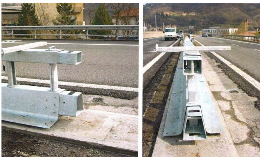
Foto 3 – detail spoja pre rýchle otvorenie
