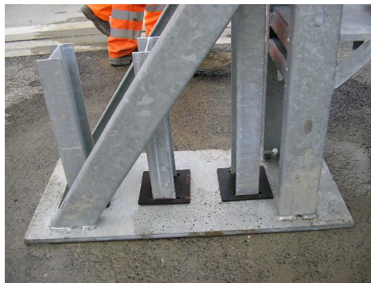
Obr. 7b: Krajná kotevná časť- demontovateľné kotvenie
