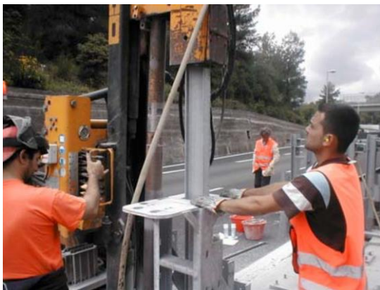
Obr. 8: Inštalácia kotviaceho I profilu na prednú krajnú kotvovú časť
