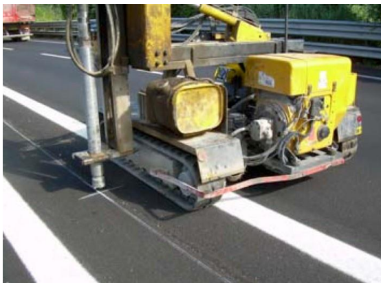
Obr. 1: Vrtanie dier pre objímky pre kotevné stĺpiky
