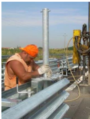
Obr. 4: Zasuňtie kotevného stĺpika
