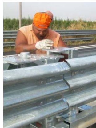
Obr. 6: Inštalácia spojovacích čapov
