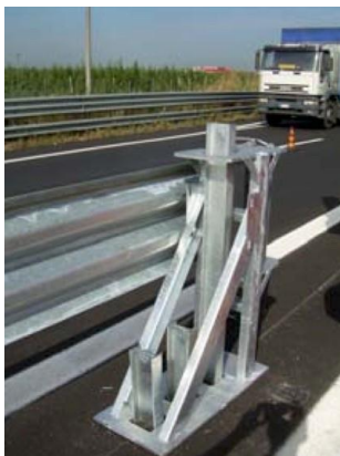
Obr. 7a: Krajná kotevná časť-pevné kotvenie
