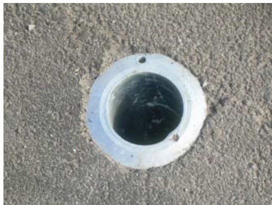
Obr. 2: Nainštalovaná objímka
