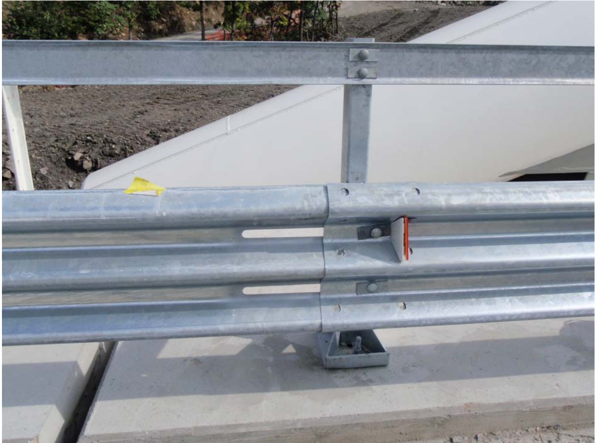
Obrázok 31 – Dilatácia zvodnice u zábradľového zvodidla
