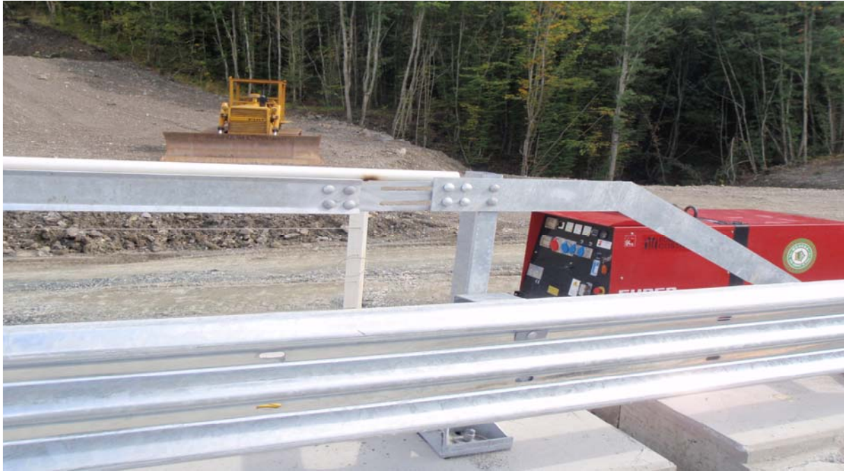
Obrázok 32 – Dilatácia madla u zábradľového zvodidla
