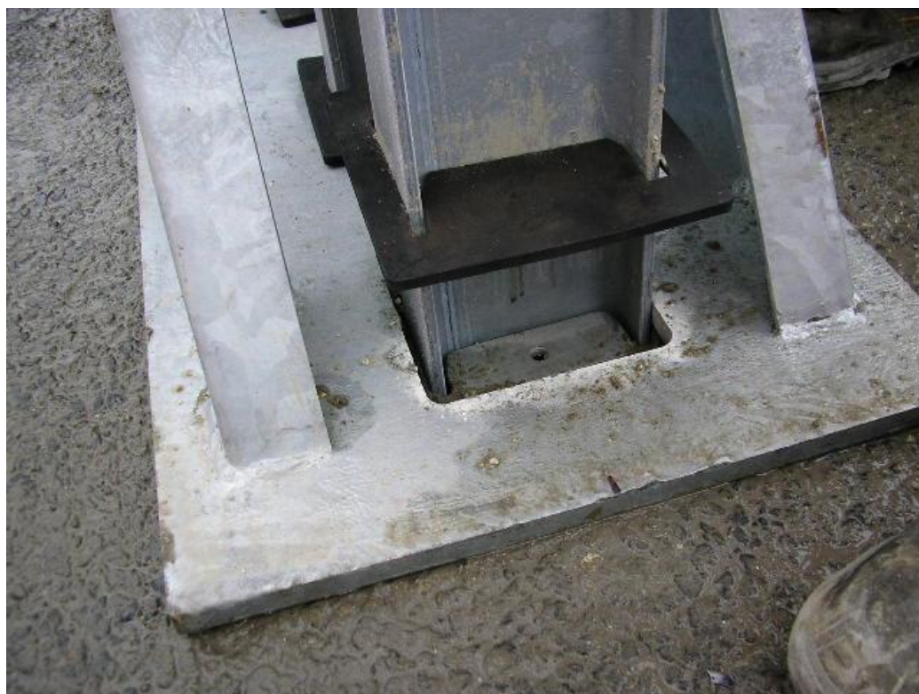
Obrázok 4 – 2 pohľady na demontovateľné kotvenie pre 3 profily IPE 120
