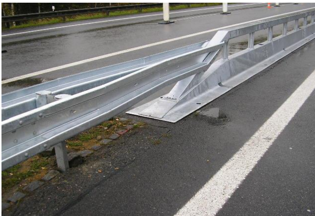
Obrázok 10 - Foto priameho napojenia Varioguardu a Varioguardu MÜF na obojstranné oceľové zvodidlo NHKG
