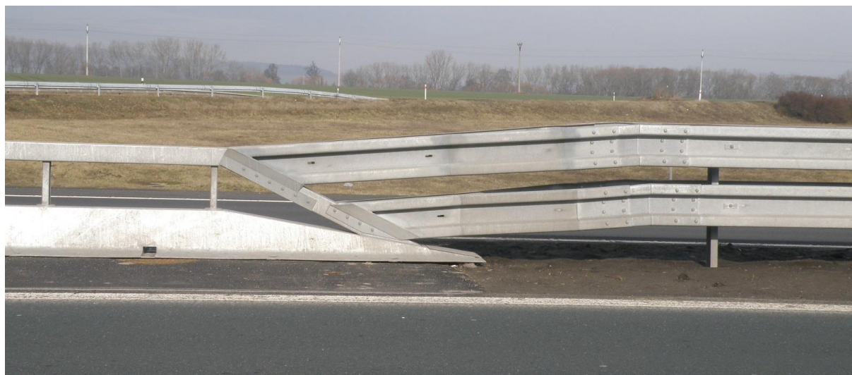
Obrázok 11 - Foto priameho napojenia Varioguardu a Varioguard MÜF na obojstranné oceľové zvodidlo OSNH4/H3
